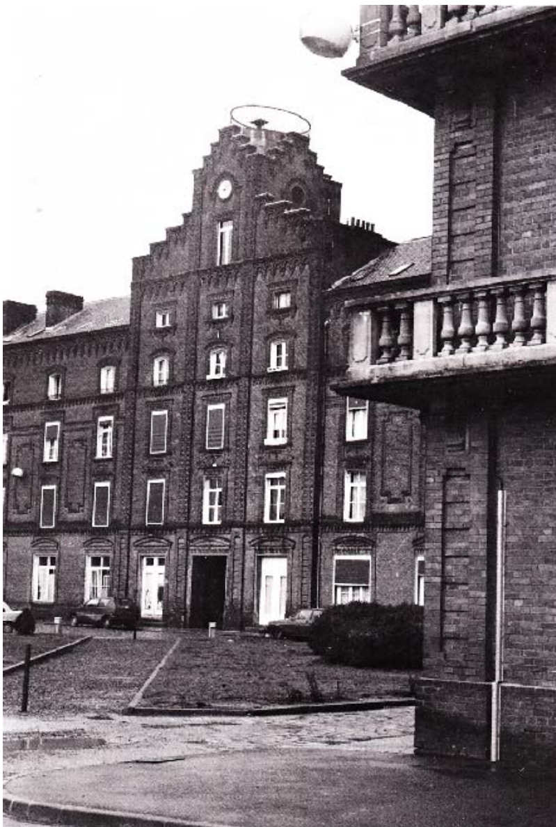
Le bâtiment central du familistère de guise avec la tour de l'horloge inspirée par le « phalanstère » de Fourier.
